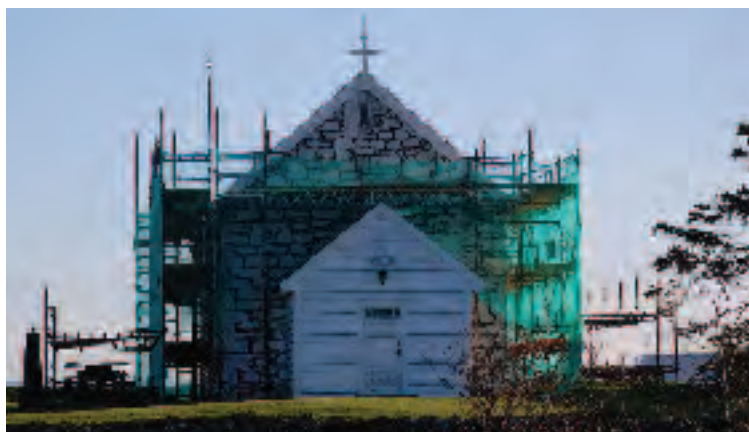
avhogging av utvendig murpuss, høsten 2008
